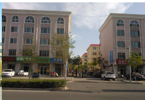
左营开元小区节能改造后外观
