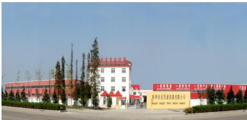
企业厂区大门口实景
