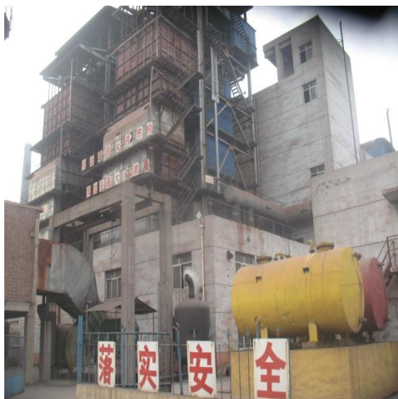
15MW 高炉煤气发电主厂房
