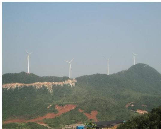
湘电新能源公司鲁荷金项目采用湘电集团生产的 96 型永磁直驱型风机，相对于其他机型，该机型更适应南方低风速风场的要求，能更好地保障风电场的平稳运行，而且能耗较少、后续维护成本低。本项目是目前湖南省装机容量最大、建成时间最快、扫风面积最大的风电。
